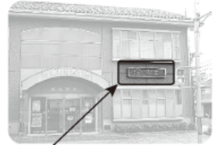
電光掲示板設置場所
